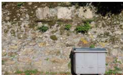
Foto 16. Muro en Corcubión
